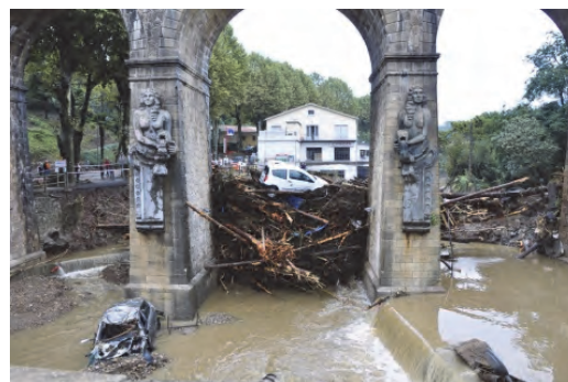
Accumulation d'embâcles, Lamalou-les-Bains (34)
