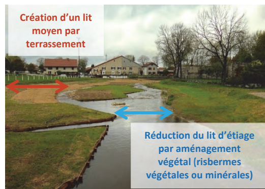
Le principe des lits emboîtés à Bouverans, SMMAH
