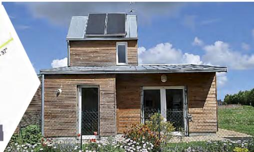
Dans le secteur de la Hunaudaye, des panneaux solaires sur les toits permettent de fournir l'eau chaude à chaque logement. De grandes ouvertures dans les pièces de vie au Sud laissent largement pénétrer la lumière et la chaleur du soleil, tandis que les chambres au Nord restent plus fraîches.
