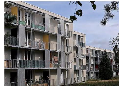
Les bâtiments sauvegardés ont connu une complète rénovation, intérieure et extérieure : changement de la plomberie, des sanitaires, du chauffage, de l'électricité... Pour les façades, la principale transformation tient à l'élargissement des balcons. Ils faisaient 1 mètre de large, ils font aujourd'hui 1,40 mètre... on peut désormais manger dehors !
