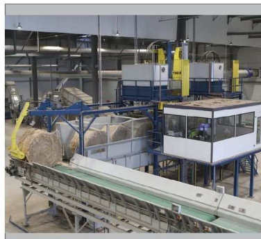
TOUT EST PILOTÉ DEPUIS UN POSTE DE CONTRÔLE d'où un employé surveille sur écran l'avancée des balles de chanvre de 400 kg chacune. Des guillemettes viennent les couper, avant que la paille ne poursuive son chemin sur un parcours automatisé.
