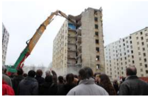
Démolition à Elbeuf-sur-Seine Source : Mairie d'Elbeuf-sur-Seine
