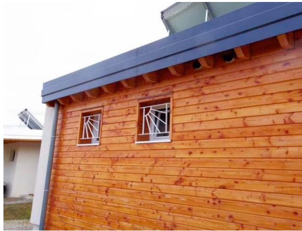
Une façade nord (source image : LET, 2013)
